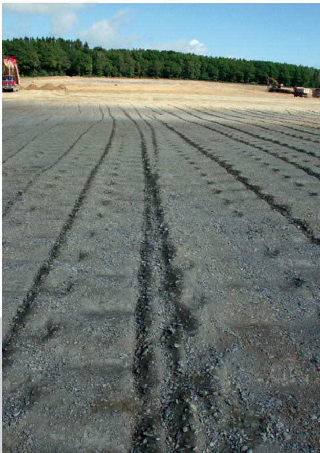
Walzenspur Polygonwalze, Bomag BW 226 DI, Erweiterung Gewerbegebiet Humos, Morbach
